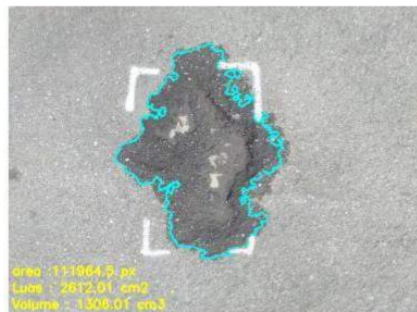
Gambar 4.14 Gambar Jalan Lokasi Kedua
