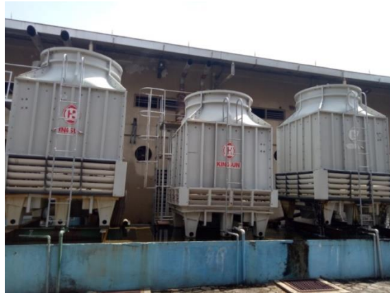
Gambar 4. 6 Sistem Pendingin Luar pada Generator Cummins
