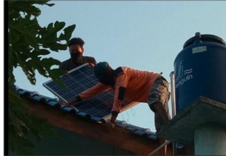
Gambar 16. Pemasangan Solar Panel di Pondok Jaga
