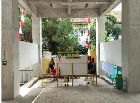
Gambar 10 Pekerja merokok di shelter merokok
