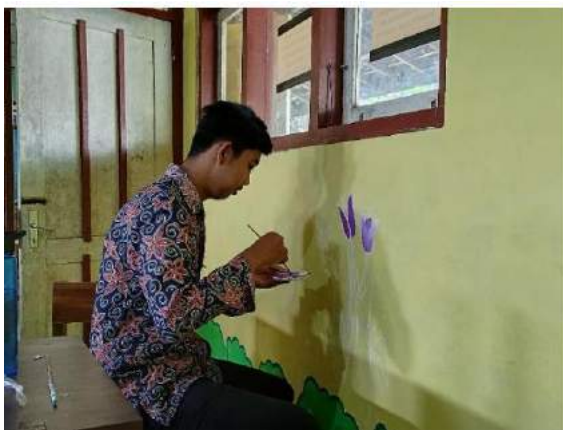
Mengecat dinding kelas 4
