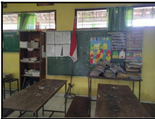
Pengamatan kondisi ruang kelas
