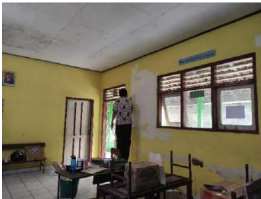
Membarsihkan Cat Lama Pada Dinding Kelas 2
