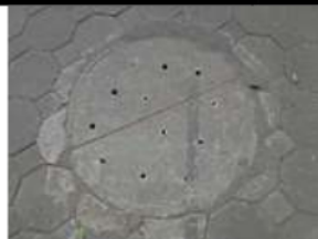
Gambar 2. Sumur Resapan
