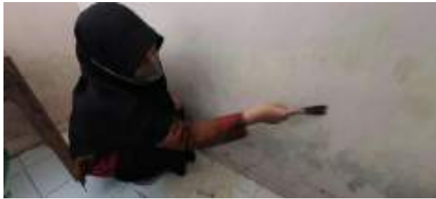
Gambar 2. Membersihkan tembok UKS sebelum dipasang wallpaper .
