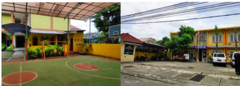
Gambar 1 Gedung mitra tampak depan dan tampak dalam
