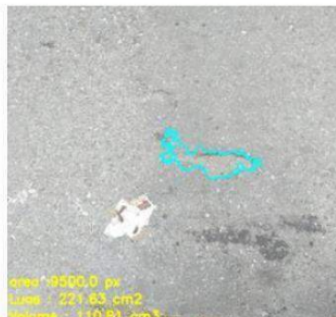
Gambar 4.15 Gambar Jalan Lokasi Ketiga
