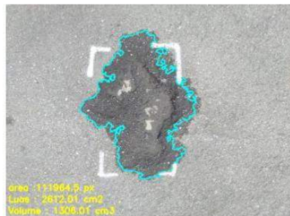
Gambar 4.14 Gambar Jalan Lokasi Kedua
