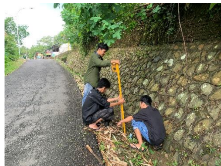
Pemasangan Penunjuk Arah
