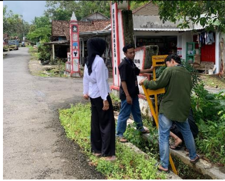
Pemasangan Plang petunjuk arah
