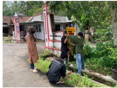
Pemasangan Penunjuk Arah
