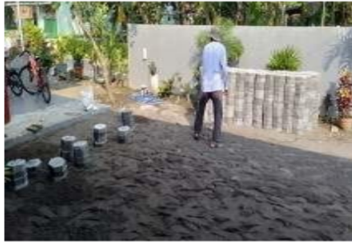
Gambar 5: Pemasangan konblok
