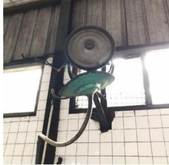
Gambar 1.19. *Humidifier* Ruang Oksidasi Enzimatis (Fermentasi)
