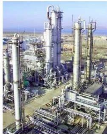
Gambar 5. Colomn yang digunakan oleh PT.KPI RU IV Cilacap ( http://www.idpipe.com/2014/08/cara-kerja-tower-atau-column.html )
