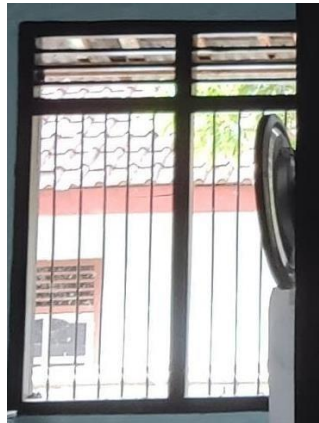
Gambar 2. 6. Jendela dan Ventilasi (Sumber: Dokumentasi Pribadi, 2021)
