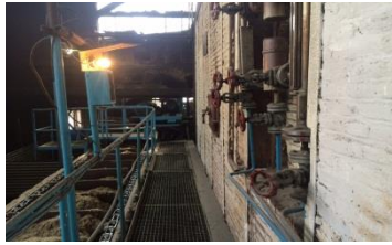
Gambar 1. Jalur Pemeriksaan Petikan Cerobong
