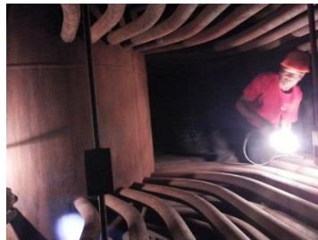
Gambar 2. Proses pemeriksaan Uji Padat ( hydrotest )
