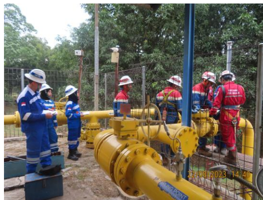
Gambar 19. Penggantian Coupon Corrosion
