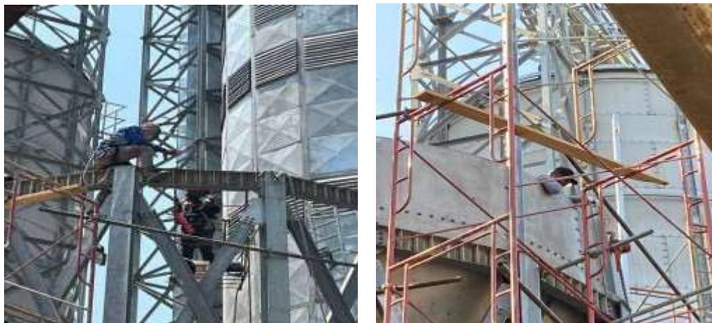
Gambar orang tidak menggunakan helm safety dan body harnes di ketinggian
