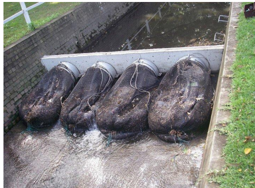
Gambar 1. Contoh bentuk dan pemasangan kantong perangkap sampah. (Sumber: Zainuddin (2019))
