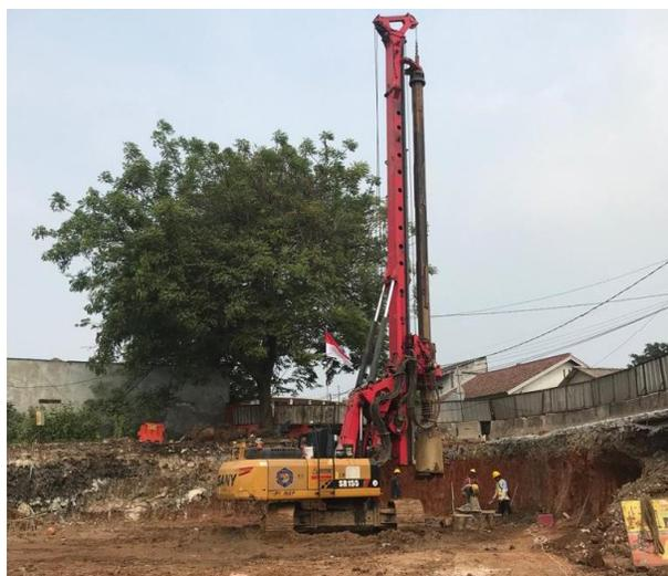
*Gambar 4. 1 Pekerjaan Bore Pile*
