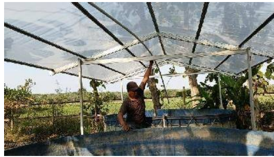
Gambar 6. Pemasangan pipa instalasi pengisian air kolam
