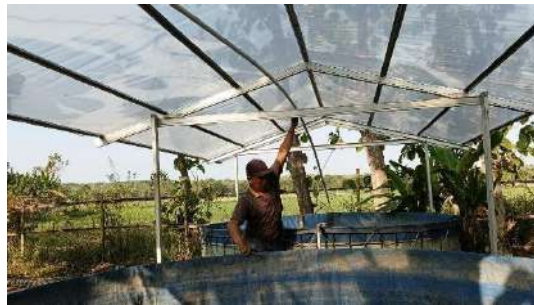
Gambar 6. Pemasangan pipa instalasi pengisian air kolam
