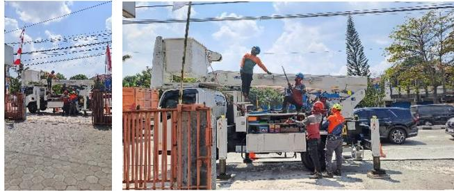
**Gambar 11.** Kegiatan Lapangan Perbaikan Recloser
