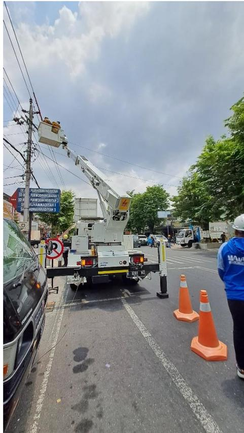
**Gambar 28.** Pembatasan Area Pekerjaan
