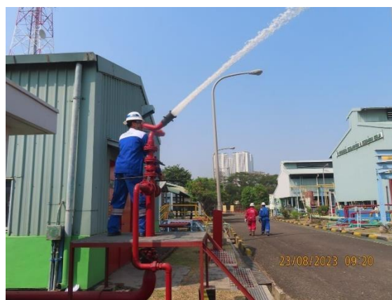
Gambar 16. Pengetesan Hydrant
