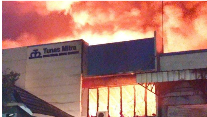
Gambar 3 Kebakaran Pabrik di Jababeka
