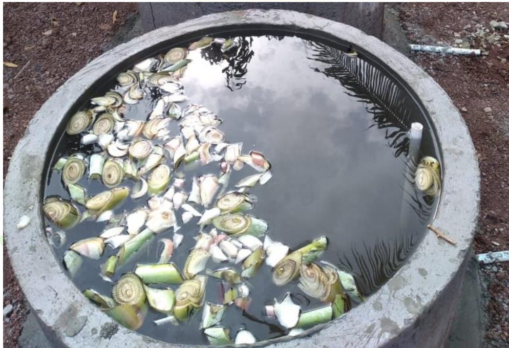
Gambar 5.8.. Pemberian pelepah pisang pada buis beton
