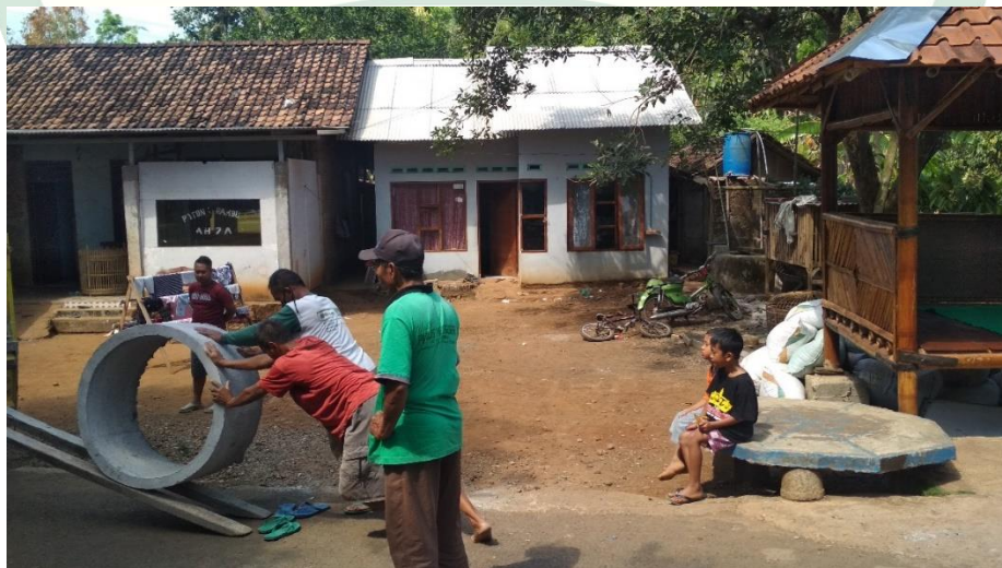
Gambar 5.3. Pemindahan Buis Beton
