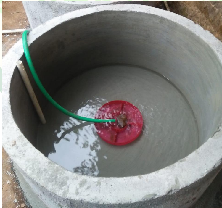
Gambar 5.7.. Pemberian air pada kolam buis beton
