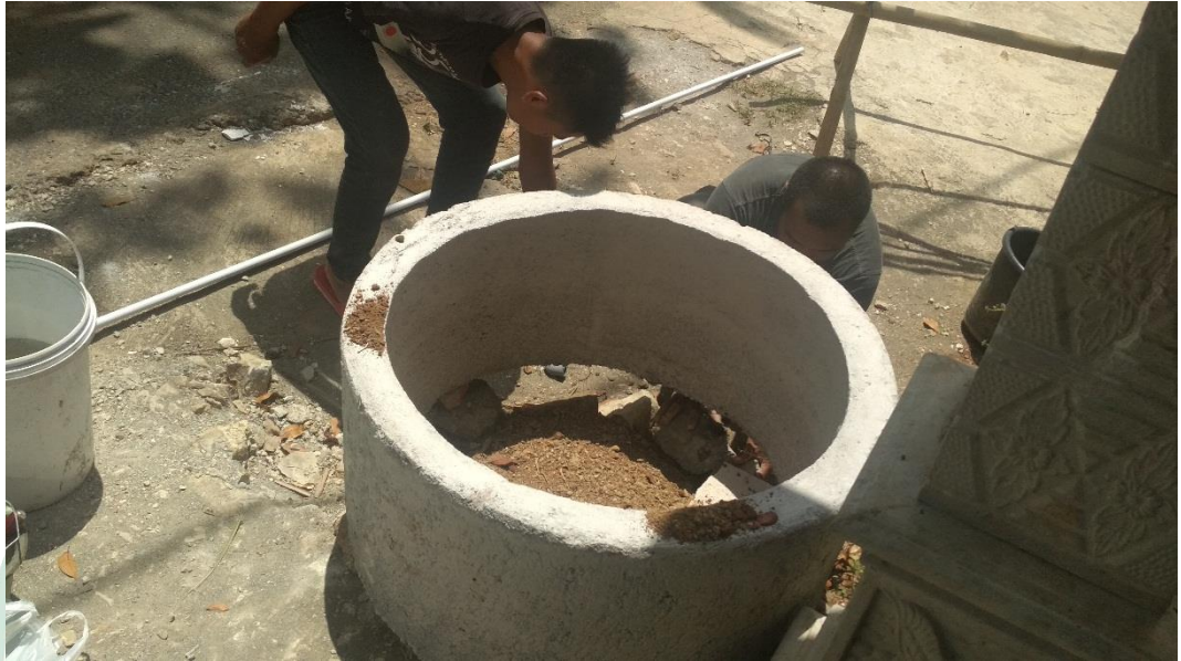
Gambar 5.4 Peletakan Buis Beton
