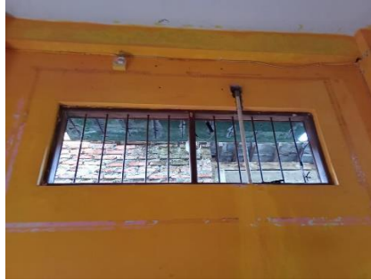
Gambar 2. 2. Ventilasi ruang produksi tanpa kasa
