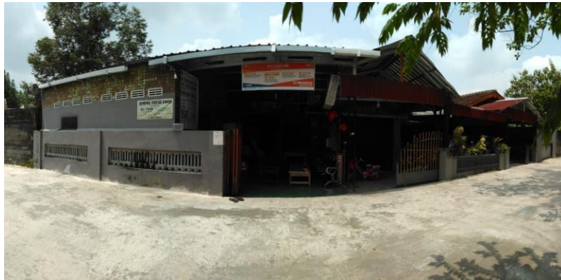
Gambar 2.2. Bangunan tampak depan Sumber: (Dokumentasi pribadi, 2023)
