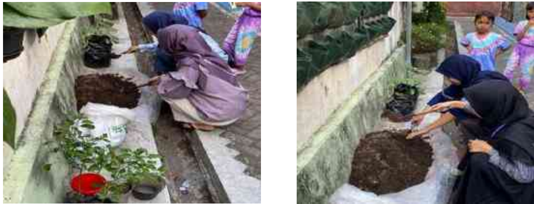
Gambar 4.3 Pemasangan media biopori
