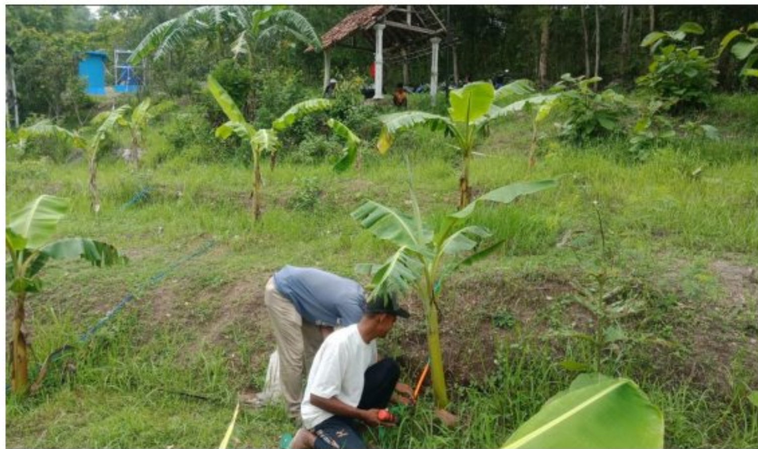
Gambar 3. Proses instalasi sistem irigasi otomatis menggunakan sensor kelembaban tanah
