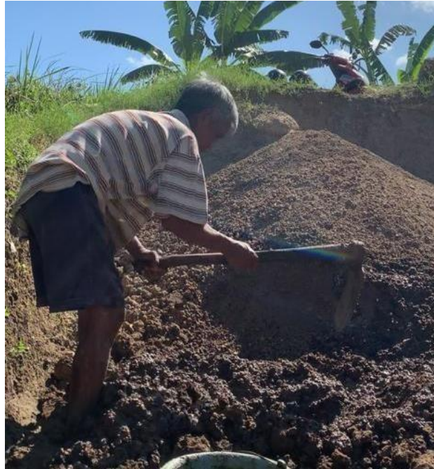
Gambar 1. 1 Proses Pengadukan Tanah Liat
