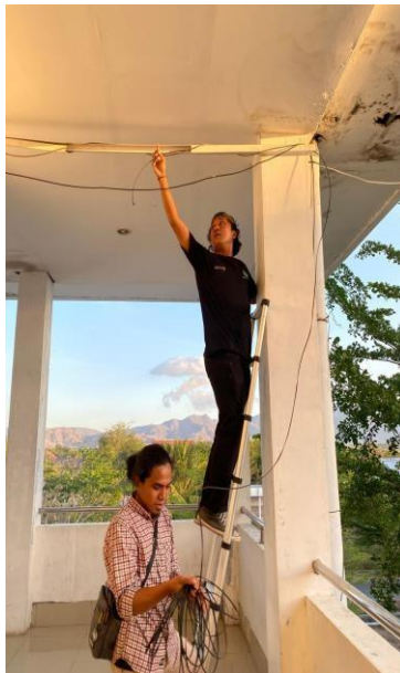
Gambar 4.6 Pemasangan Kabel FO
