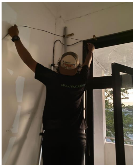
Gambar 4.2 Pemeriksaan Kabel FO
