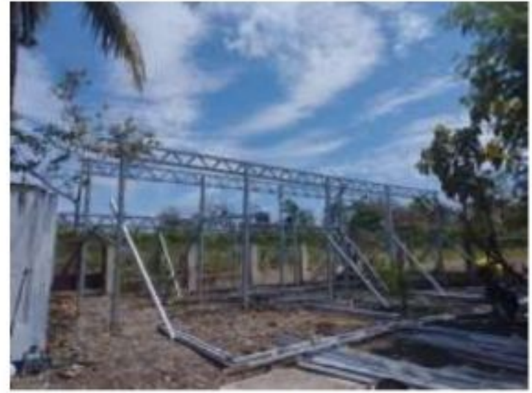
Perkembangan Pembangunan Greenhouse (28/08/2024)
