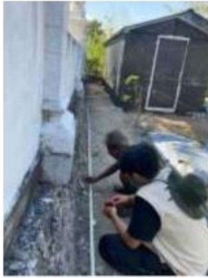
Pembangunan Pipa Air di Lahan Konservasi TOGA (05/08/24)
