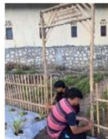
Pemasangan Pagar Taman TOGA (28/08/2024)
