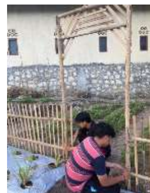
Pemasangan Pagar Taman TOGA (28/08/2024)
