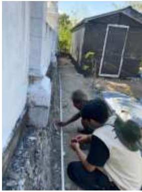
Pembangunan Pipa Air di Lahan Konservasi TOGA (05/08/24)
