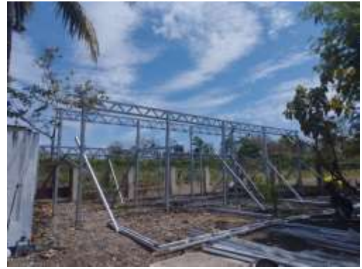
Perkembangan Pembangunan Greenhouse (28/08/2024)
