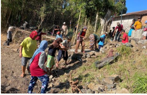
Gambar 33. Penyusunan Batu untuk Perataan Tanah
