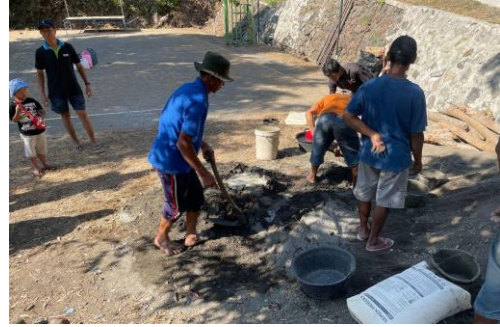
Gambar 34. Pengadukan Semen untuk Pembangunan HGC
