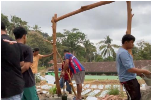
Gambar 53. Pembuatan Gapura Pintu Masuk HGC
