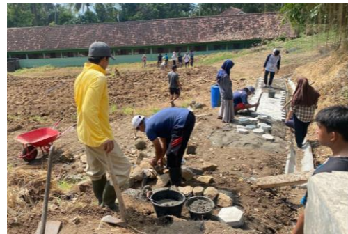
Gambar 28. Pembuatan Akses Jalan HGC
