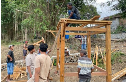
Gambar 49. Pembangunan Gazebo HGC
