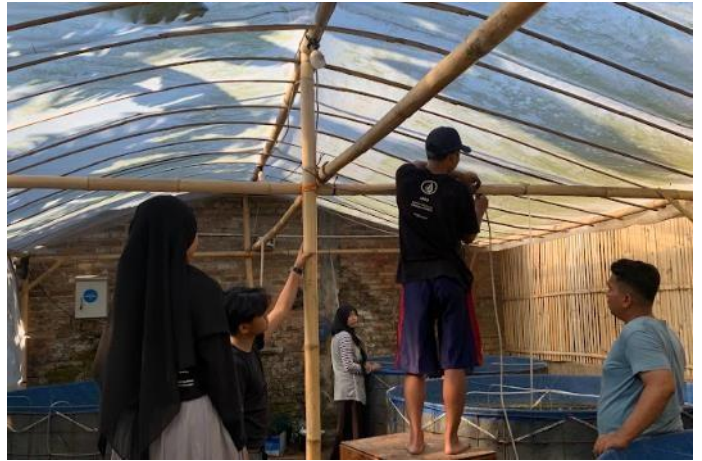
Gambar 8. Pemasangan Instalasi Listrik
