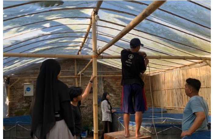
Gambar 8. Pemasangan Instalasi Listrik
