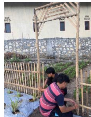
Pemasangan Pagar Taman TOGA (28/08/2024)
