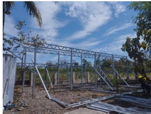
Perkembangan Pembangunan Greenhouse (28/08/2024)
