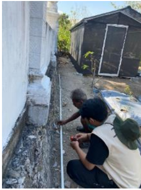
Pembangunan Pipa Air di Lahan Konservasi TOGA (05/08/24)
