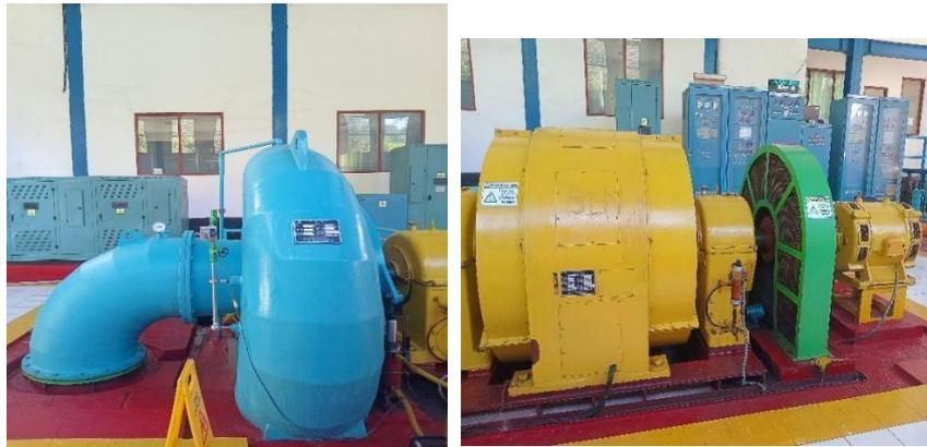
**Gambar 3.15.** Turbin dan Generator PLTM Ndungga Ende
