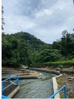
**Gambar 3.14.** Saluran Pembuangan (*Tailrace*) pada PLTM Ndungga
