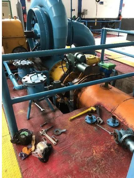
**Gambar 3.9.** *Main Inlet Valve* pada PLTM Ndungga
